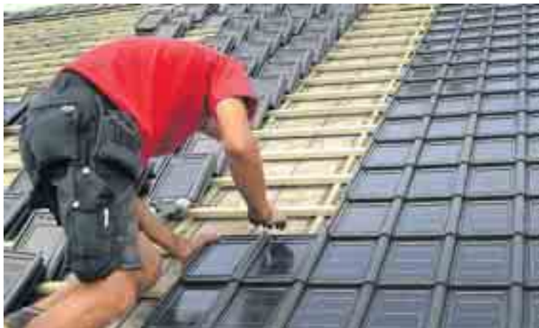
De zonnepannen worden aangebracht zoals klassieke pannen. © Smartroof
