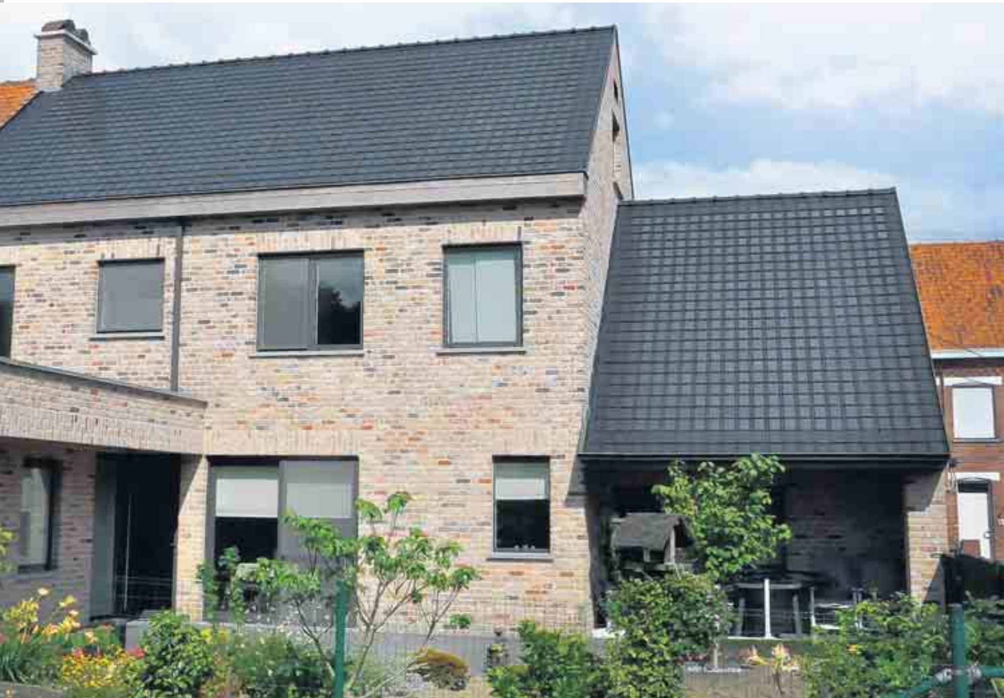
Op het eerste zicht lijken de zonnepannen gewone dakpannen. © Smartroof
