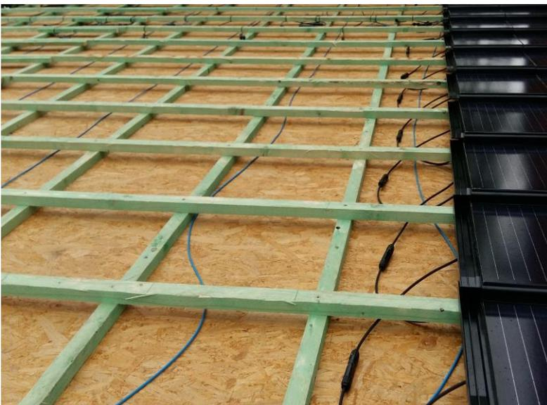
Maintenant que le lattage est en place, les câbles de chaque string peuvent être mise. Un bout du câble est connecté avec les tuiles solaires sur la sous toiture et l'autre bout sera raccordé avec l'Optimiseur SolarEdge à l'intérieure du bâtiment.
