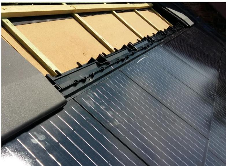
Chaque tuile est vissée sur le lattage . Elle est clipsée dans la tuile du bas par un crochet intégré. Ainsi nous obtenons une toiture solide , compacte et homogène. Le poids total après placement fait uniquement 18 kg/m<sup>2</sup> !
