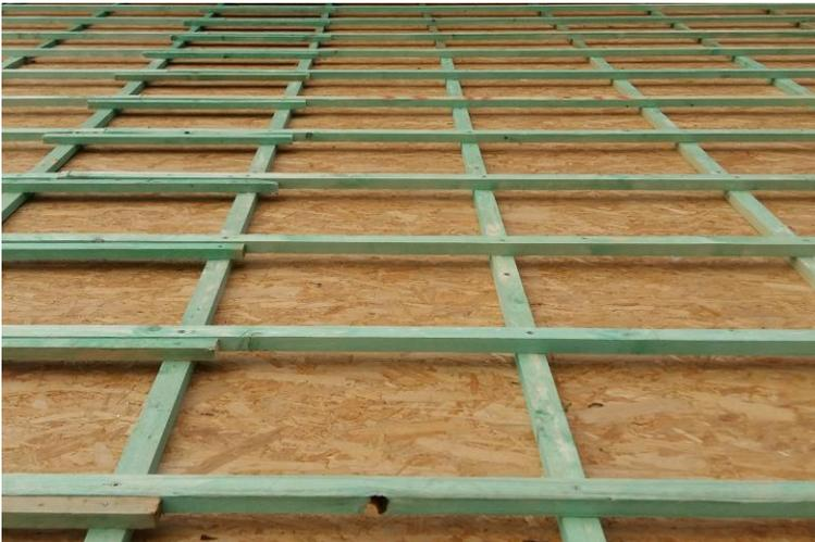
Pour la Cerasolpan une distance entre les lattes ( top / top ) de **40.8** cm est nécessaire. Une fois que le lattage est en place, une distance entre chaque tuile solaire de **35.2** cm est tracée. Le contre lattage doit faire minimum 20 mm de haut pour augmenter la ventilation et de pouvoir passer les connecteurs en dessous le lattage.
