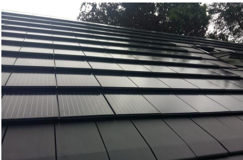
Le raccord électrique entre les tuiles solaires est simple : deux connecteurs MC4 qui se cliquent l'un dans l'autre et la connexion est faite! Chaque tuile solaire a son propre bypass diode. En cas de défaut, le circuit électrique n'est pas interrompu.
