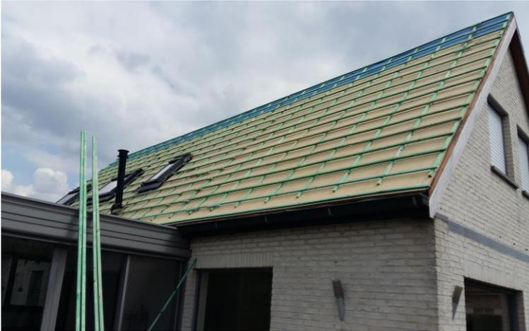
La tuile solaire de Smartroof est placée sur une toiture comme la tuile classique tant pour les rénovations de toiture que pour les bâtiments neufs. La sous toiture est la même comme avec des tuiles céramiques.
