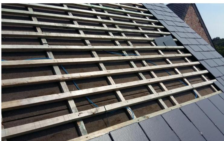
Pour l'Ardoise solaire une distance de lattage à **14.6** cm est obligatoire. Les dimensions de l'Ardoise solaire font 1140 x 400 x 5 mm. Le contre lattage doit faire minimum 20 mm de haut pour augmenter la ventilation et de pouvoir passer les connecteurs en dessous le lattage.
