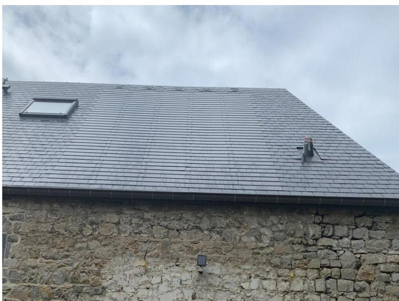
La finition du toit peut se faire en combinaison avec l'Ardoise naturelle Cupa, Samaca, Gaëlic, ... 40/22 , mais aussi avec l'Ardoise synthétique New Stonit 40/24. Ventilation en haut près du faitage est nécessaire pour obtenir une ventilation naturelle de la sous toiture pour refroidir les ardoises solaires.
