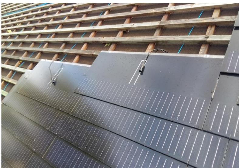
La raccord électrique entre les Ardoises solaires est simple : deux connecteurs MC4 qui se cliquent l'un dans l'autre et la liaison électrique est faite ! Chaque Ardoise solaire a son propre bypass diode. En cas de défaut d'une Ardoise solaire, le circuit électrique n'est pas interrompu.
