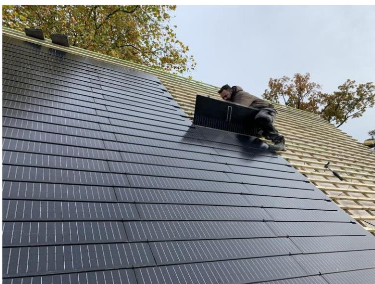
Après le lattage la distance entre chaque Ardoise solaire est **114.3** cm. Maintenant les câbles solaires sont mis en place. Le raccordement des strings avec les Ardoises solaires peuvent se faire, ainsi le raccordement avec les Optimizers et/ou l'onduleur à l'intérieure du bâtiment.
