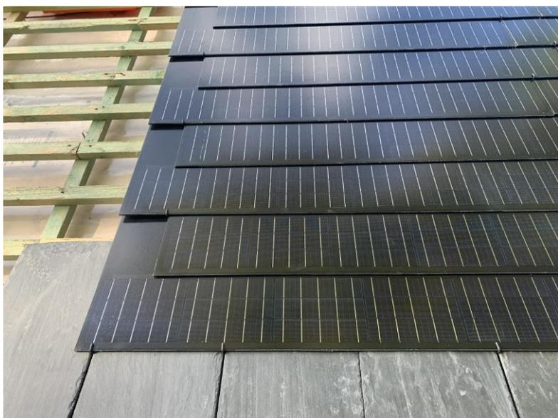
Chaque Ardoise solaire est vissée sur le lattage avec deux vis . Un crochet spécifique est en place pour obtenir une toiture solide , compact et homogène. Le poids total après placement fait uniquement 24 kg/m<sup>2</sup> !
