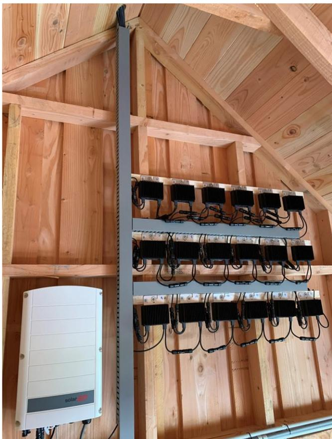
Le branchement au réseau se fait comme des panneaux photovoltaïque. Nous proposons d'utiliser la technologie SolarEdge ainsi vous pouvez installer directement ou plus tard une batterie et/ou un chargeur pour une voiture électrique!
